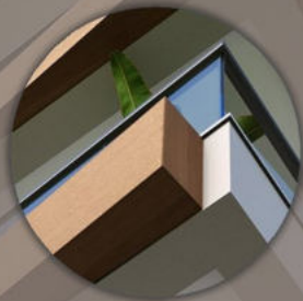
Detalhe na fachada em ACM
